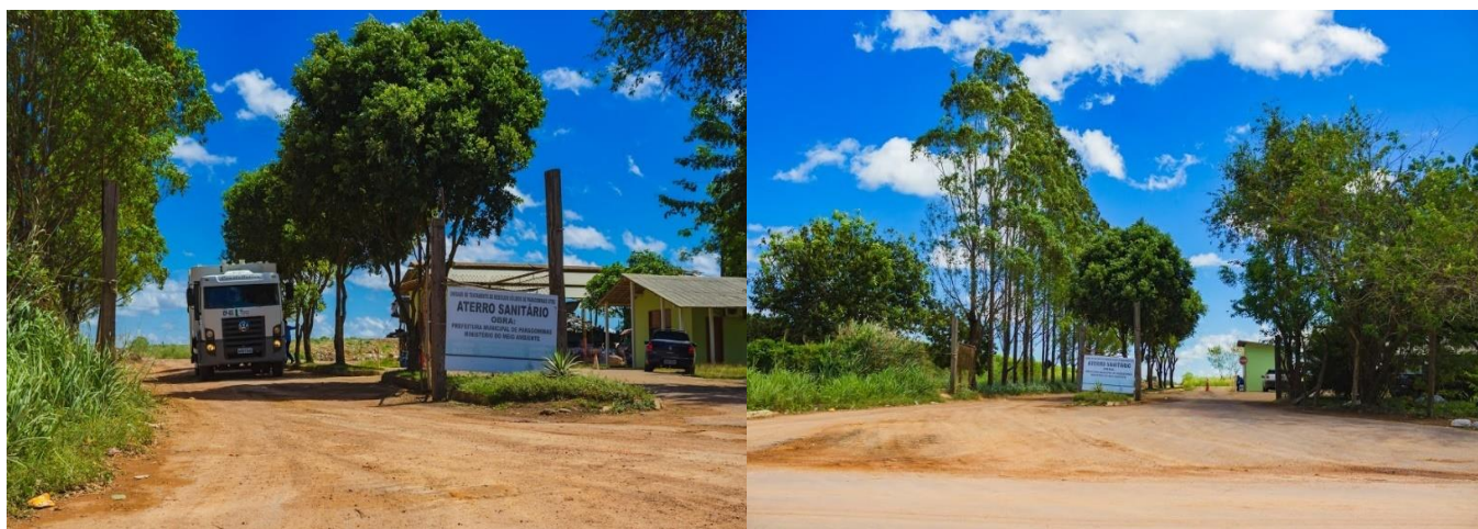
Figura 31 - Entrada do Aterro Controlado.
