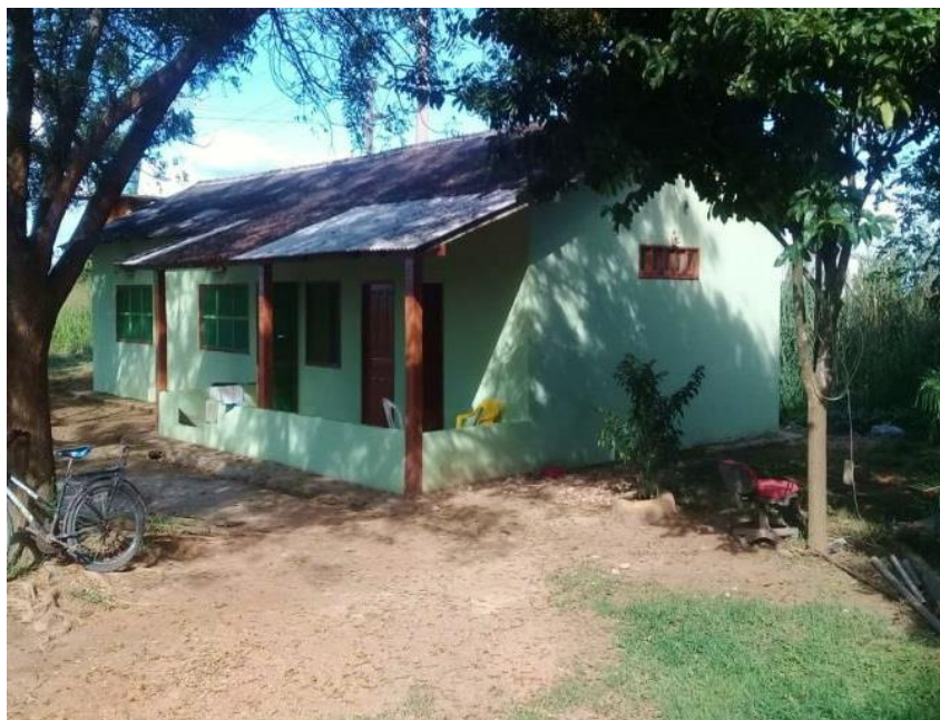
Figura 35 - Sede da Cooperativa de catadores.
