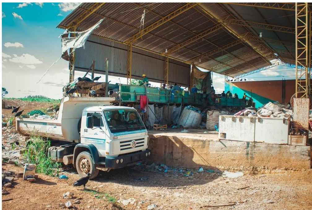
Figura 19 - Galpão de triagem.
